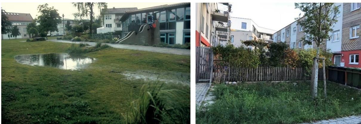
Abbildung 17: Integration einer Mulde in eine Grünfläche (links) oder in einem abgegrenzten Bereich (rechts) (HL)
