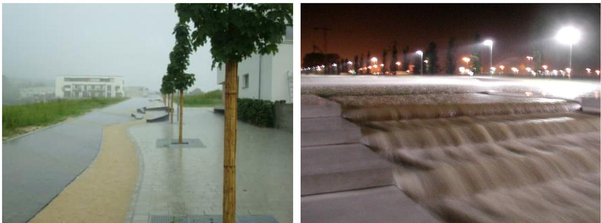
**Abbildung 31: Ableitung eines Starkregenereignis über den Querschnitt der Verkehrsflächen oder eingeplante Notwasserwege im Gelände (HL)**
