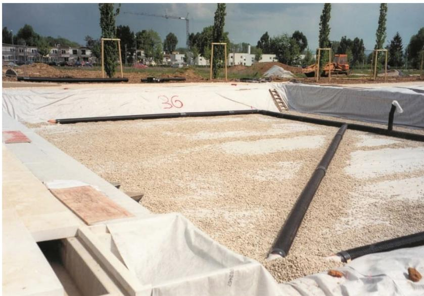
Abbildung 18: Aufbau einer Kiesrigole: Filtervlies, Kiespackung, Drainageleitung und Einlaufschacht (HL)
